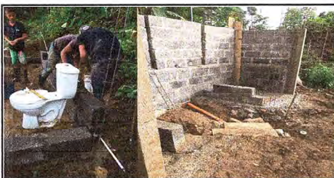
Foto 5: Foto de avance en la sustitución de pared de los baños del centro educativo, así mismo de la colocación de sistema de tuberías, fosa séptica y el abastecimiento de la red de agua.
