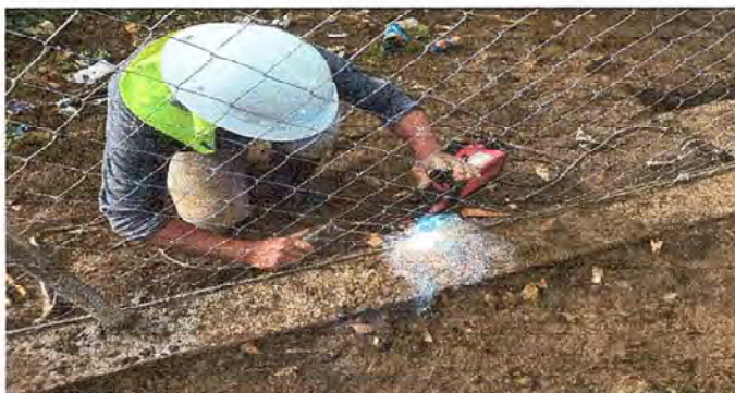
Foto 6: Soldadura para el tensado de la malla, para el cerco perimetral.
