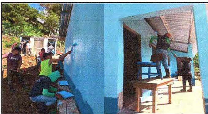
Foto 4: Limpieza y pintada de los muros interiores y exteriores del centro educativo.
