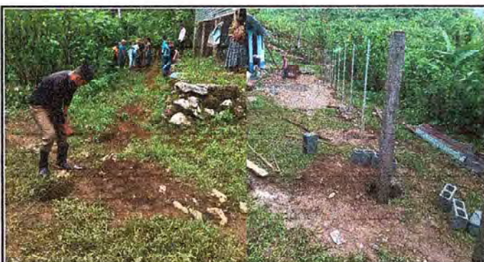
Foto 3: Se observa los agujeros en donde serán fundidas las columnas que sostendrán el portón, así mismo los agujeros en donde el albañil fundirá los tubos galvanizados.
