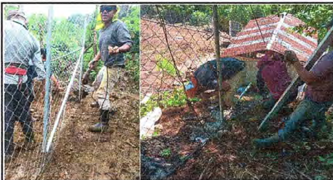
Foto1: Estirada y tensada de la malla en la circunvalación del área del centro educativo.
