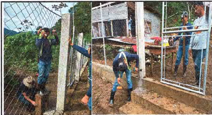
Foto 2: Instalación y colocación del portón de la entrada del centro de estudios.
