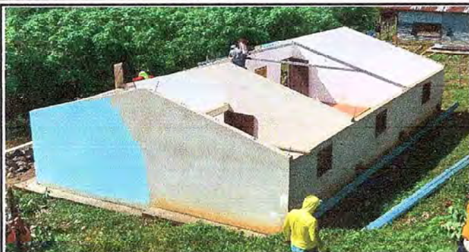
Foto 1: Se observa la colocación de la viga que cargará las costaneras de la estructura y la cubierta de láminas.
