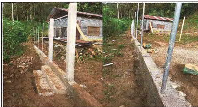
Foto 4: Desde 2 ángulos se observa el avance del muro perimetral y la base del cerco perimetral.
