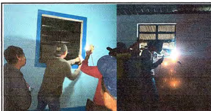
Foto 5: Instalación y colocación de las ventanas del centro educativo.
