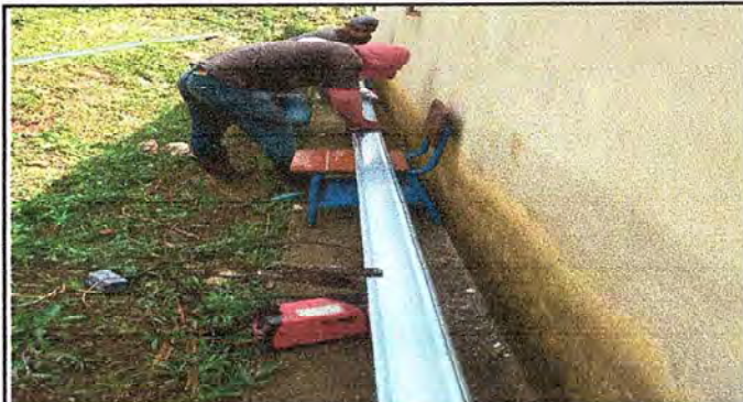
Foto 2: El herrero está uniendo las costaneras que se utilizarán para la estructura de techo.
