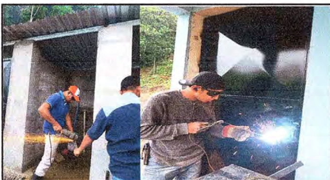
Foto 3: Instalación de Puertas del aula, Dirección y los baños.
